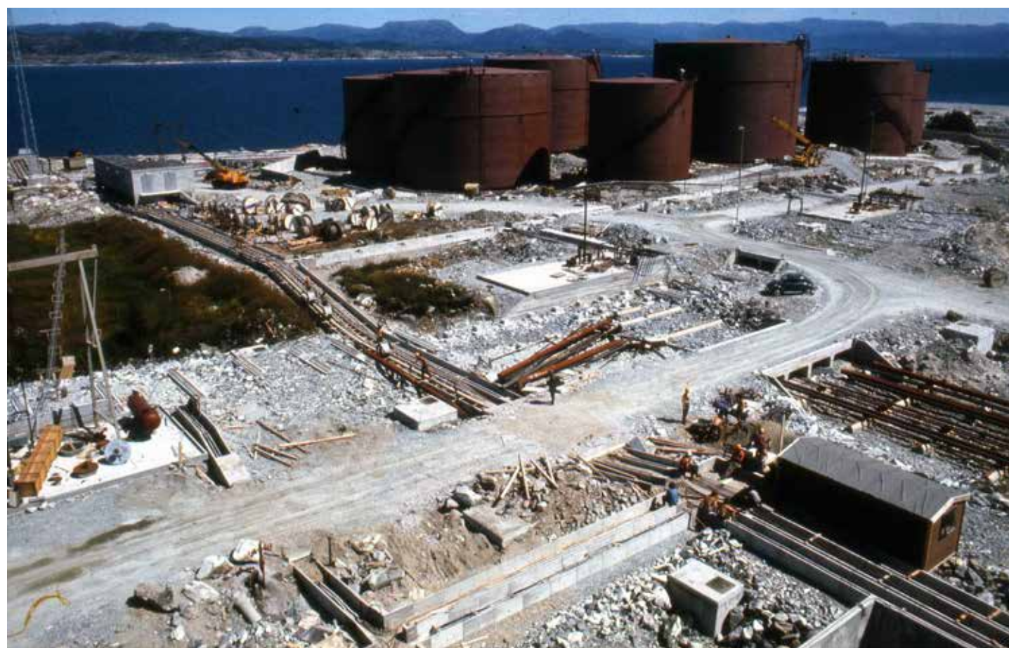
Bygging av tanker og rørgater Offsite (Ytre anlegg)
