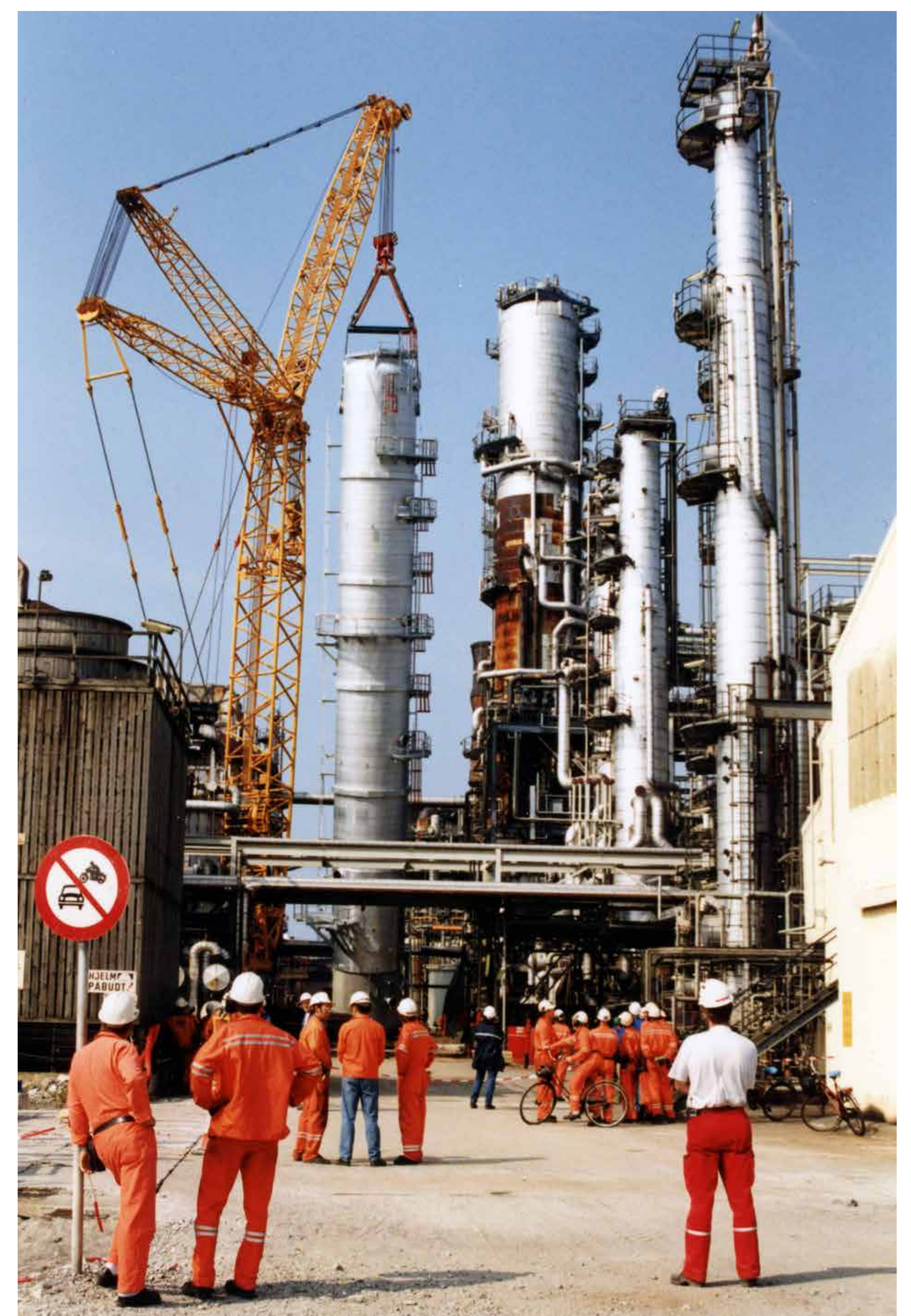
Naftasplitter T-112 heises på plass
