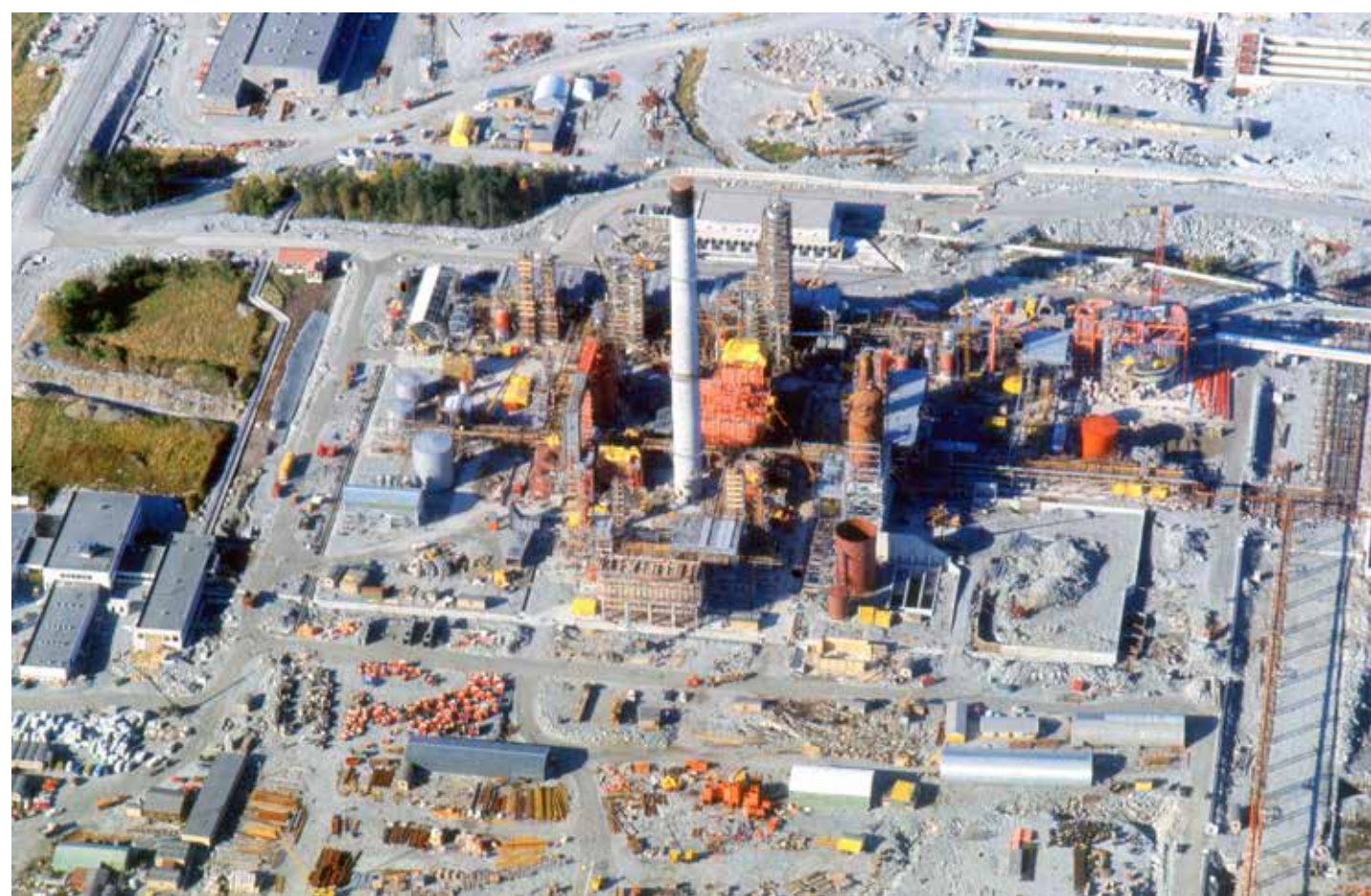
Flyfoto tidlig byggefase
