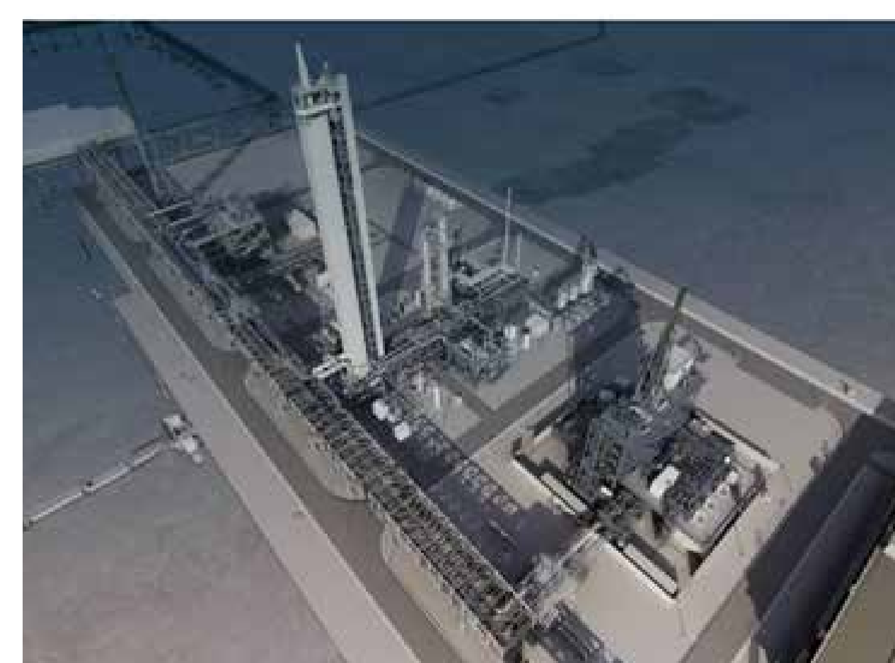
Viset Alstoms Chilled ammonim foran og Akers aminanlegg bak (CO2 fangst)
