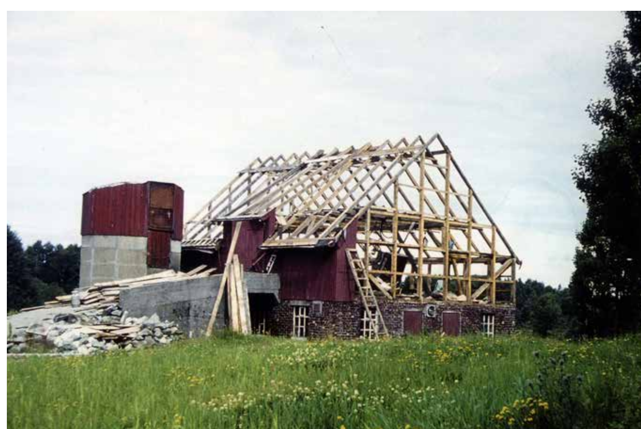
Riving av driftsbygning
