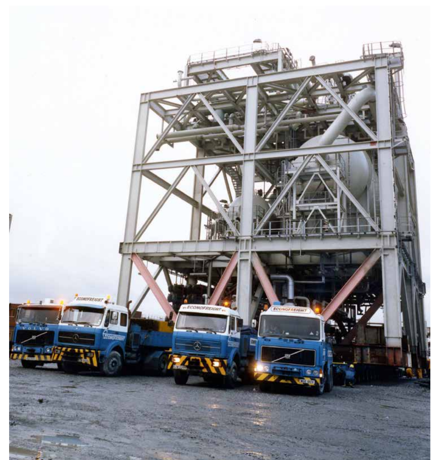
Transport av moduler til prosessanlegg
