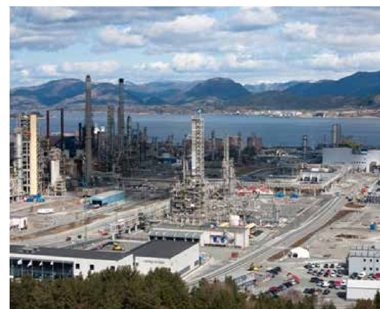
TCM anlegg med adm. bygg og anlegg (CO2 fangst)
