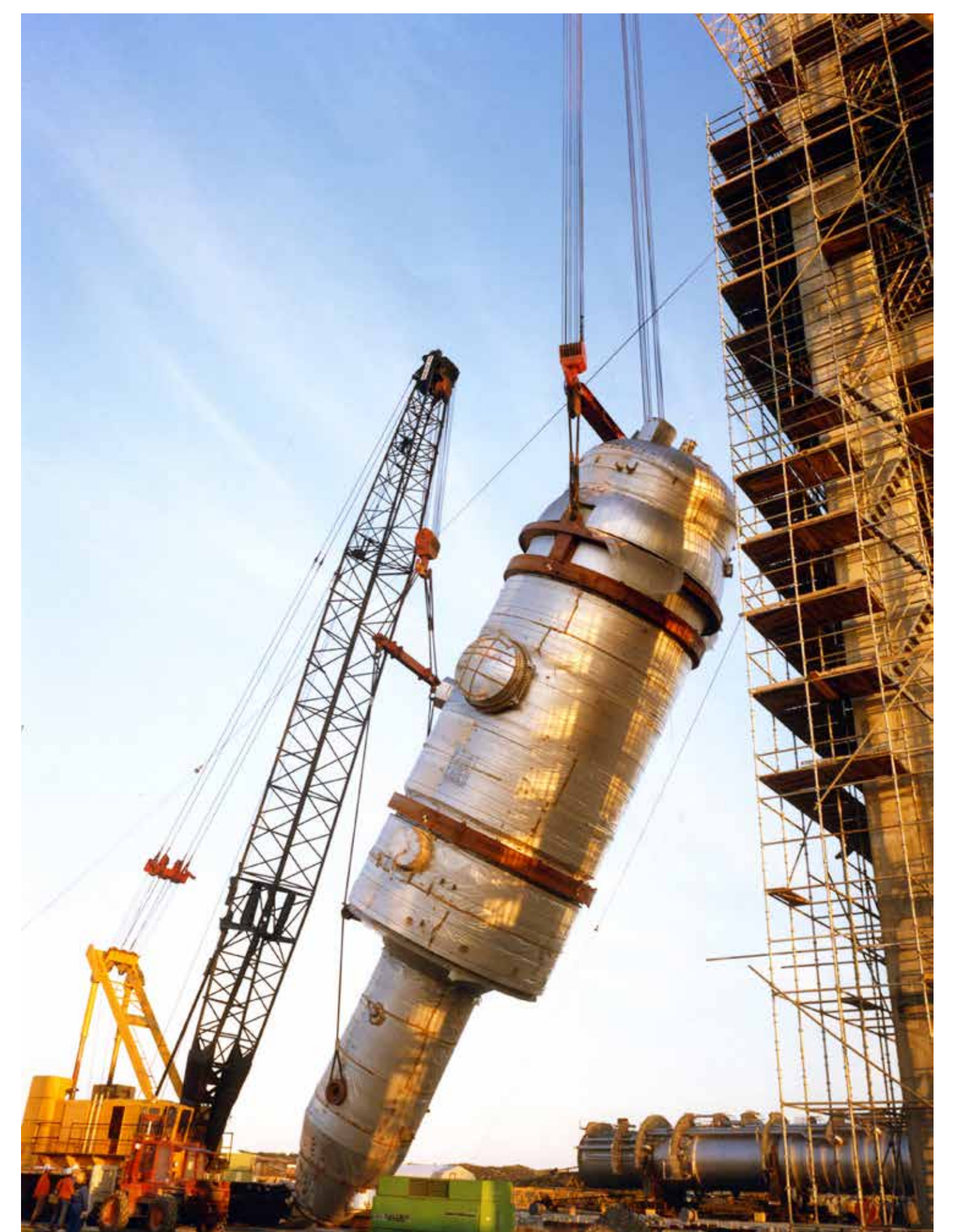
Krakker blir heist på plass i anlegget
