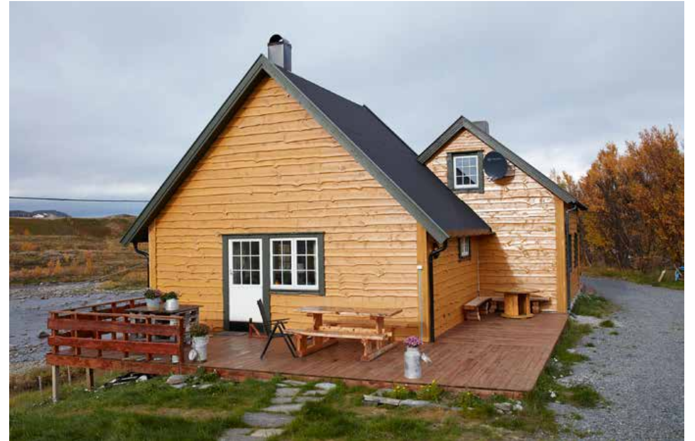
Mange av gjenreisningshusene er påbygd og ombygd flere ganger. På dette huset i Kokelv, opprinnelig et ettplanshus fra 1947, har den nye stuedelen en annen takvinkel enn den påbygde halvetasjen fra 1950. Ved påbygging i 1950 ble det gjort tilpasninger som endret takvinkelen i forhold til byggetegningene. Dette ble først oppdaget da takstolene til nybygget skulle monteres i 2012.
